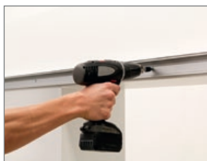
1. Installation du rail par l'avant
